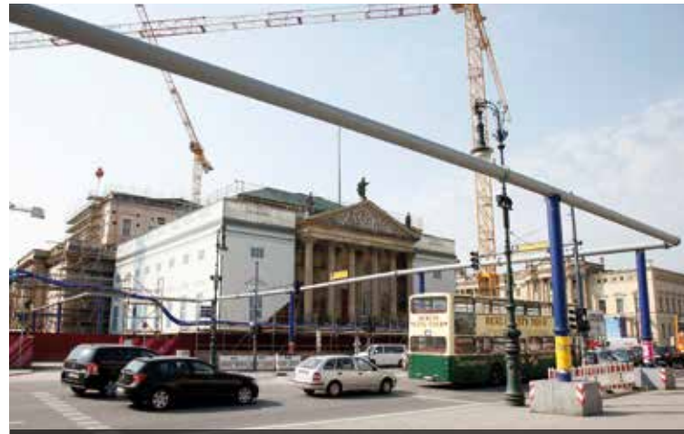
Baustelle und kein Ende? Staatsoper unter Bauplanen Foto: Chr. v. Polentz / transitfoto.de
